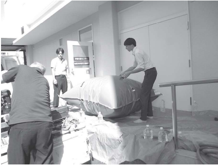
ヘリウムガスバッグから移動式圧縮機に供給する
